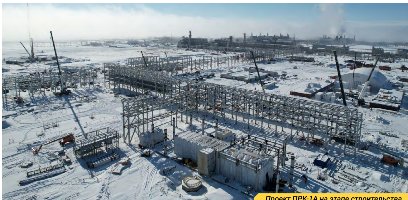
Проект ПРК-1А на этапе строительства
