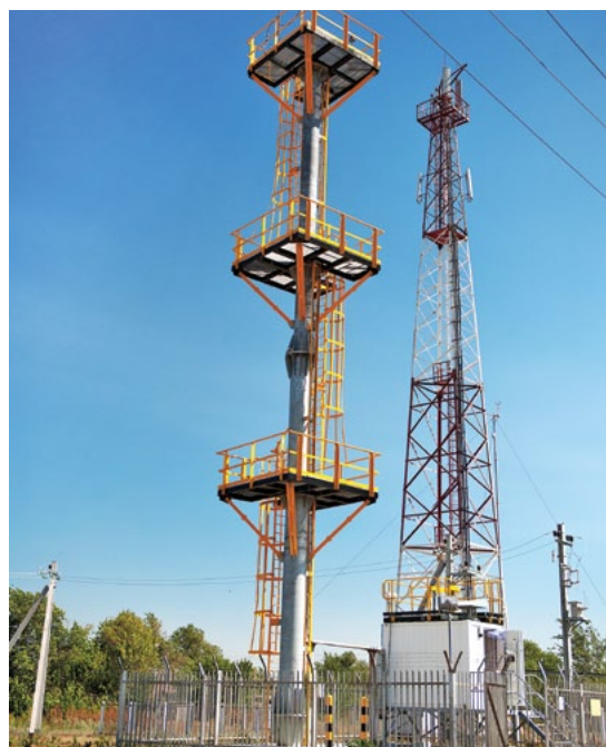
Станция экологического мониторинга КПО в селе Березовка
