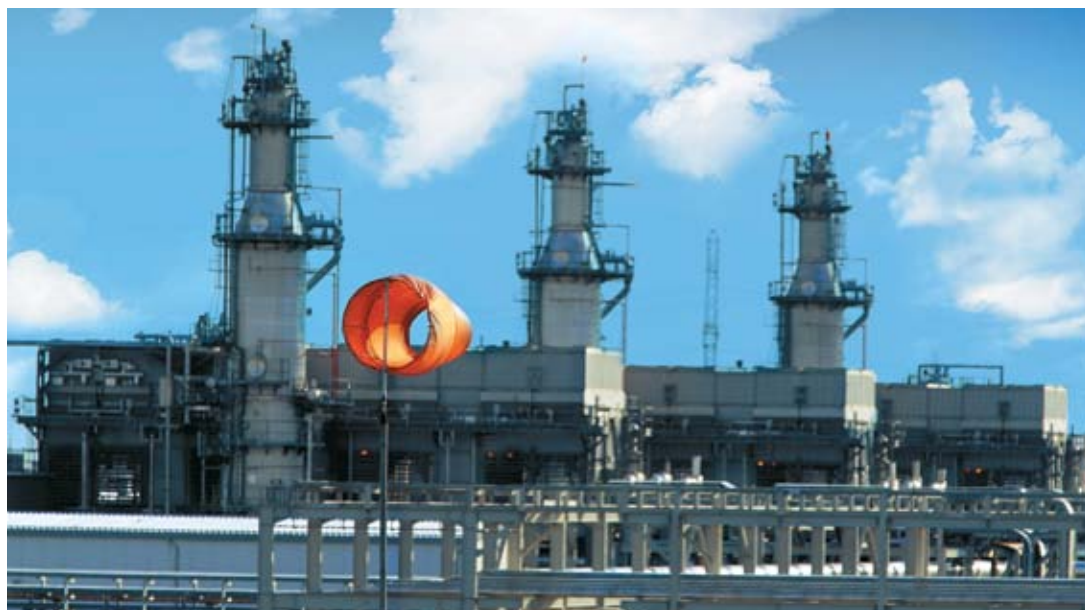
Вид Карачаганакского перерабатывающего комплекса
