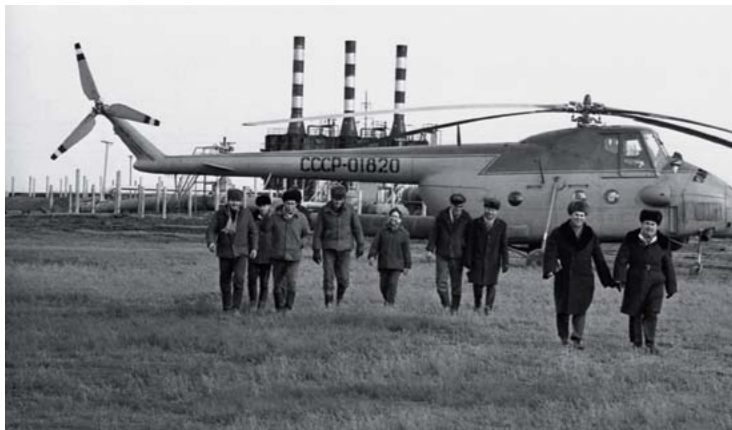
29. Завершено строительство магистрального нефтепровода Узень-Гурьев-Куйбышев, 1970 г.
